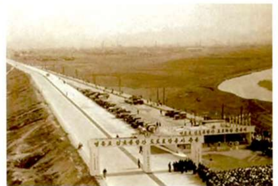
영등포-김포공항간 도로확장 준공(1962)
